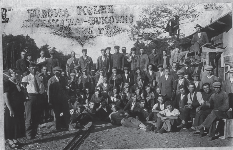
Zdjęcie budowniczych linii kolejowej ze Szczakowej do Bukowna (1935 r.). Spore wrażenie robi mężczyzna z butelką mleka, który siedzi na drzewie.
