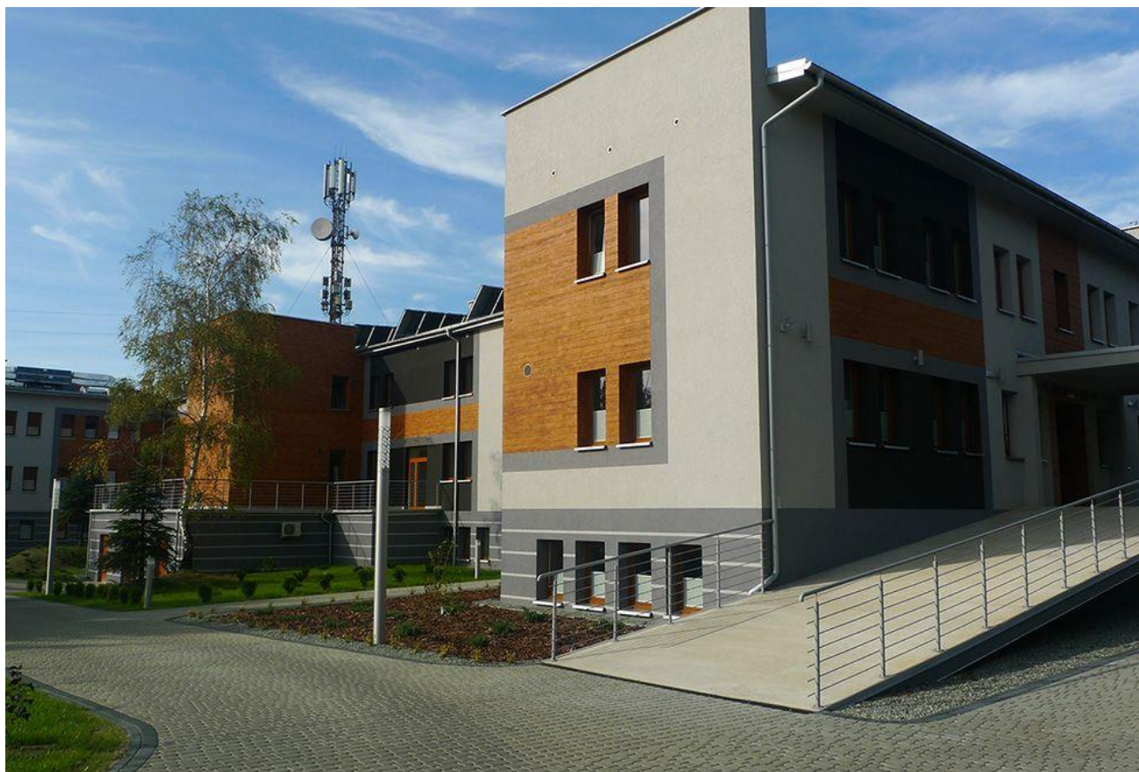
FOTOGRAFIA 2. CENTRUM MEDYCZNE „SKAŁKA” W BUKOWNIE
